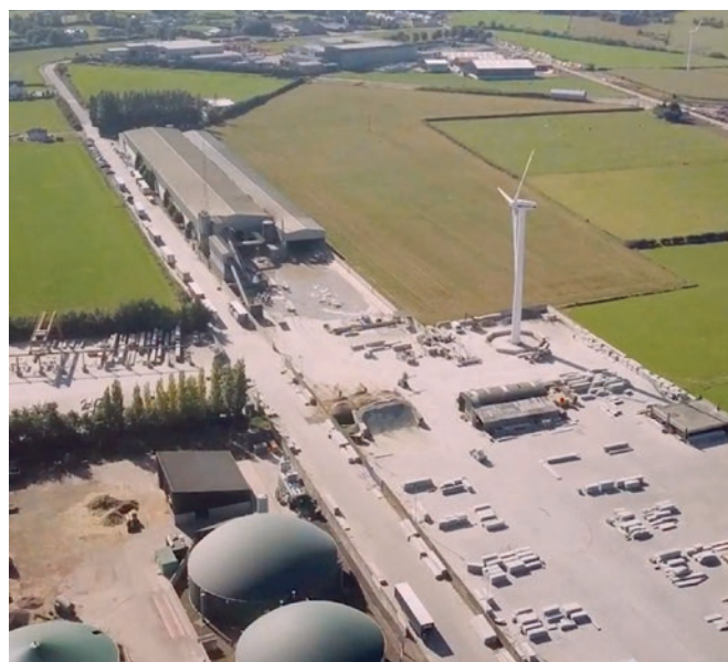
Vue aérienne du site de production de Creagh Concrete
